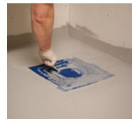
Utgjämning av rörmanchett och förstärkningsremmar.
