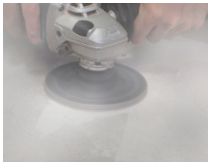
Betongslipning utan dammutsug.
