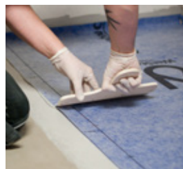
Montering av tätskiktsfolie.
