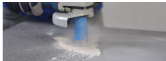
Håltagning utan dammutrug.
