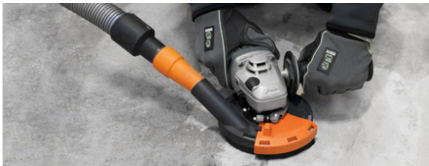
Dammfri betongslipning med dammutsug.
