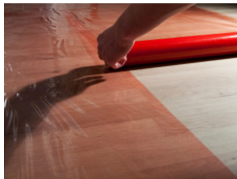
Täckfolie hårda golv Cover med självhäftande undersida.
