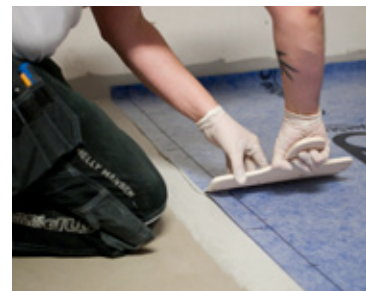
Montering av våtrumsfolie med bredspackel med plastblad.
