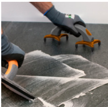
Enklare plattsättning med Stödhandtag Octo.
