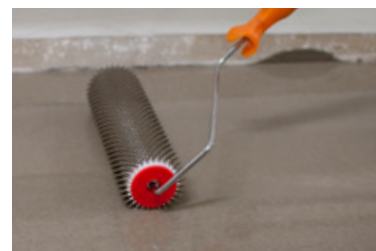
Piggröller för effektiv borttagning av luftbubblor i avjämningsmassa.
