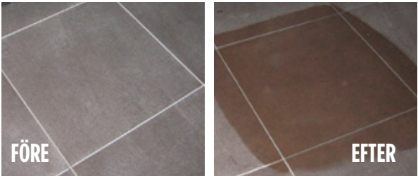
Fogrester på mörka plattor lämnar en dimmig hinna.
