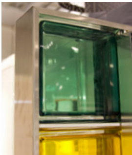
Glasbetonglister mellan glasblock med avslutningslist längs kanterna.
