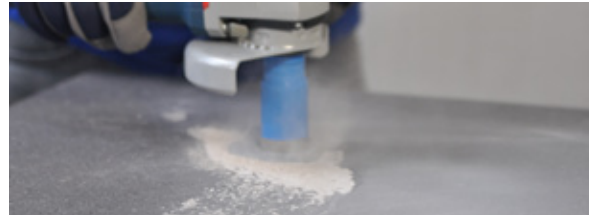
Håltagning utan dammutsug.
