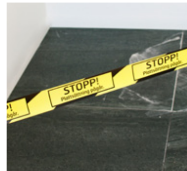
Varningstejp "STOPP! Plattsättning pågår"
