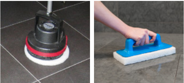
Fogrester tas bort med passande produkt och polermaskin eller skurblock.
