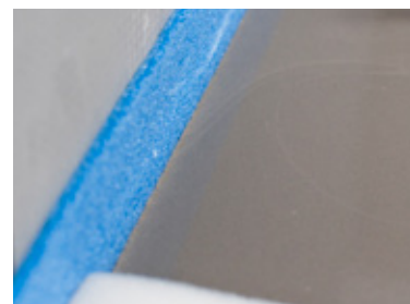
Dämpfolie/kantband för rörelseupptagning i golvkonstruktioner.
