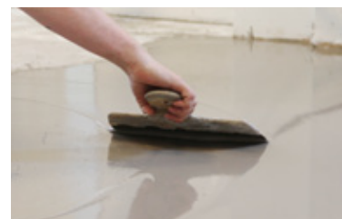
Bredspacklar för skrapning och finjusteringar.
