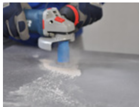
Håltagning utan dammutsug.
