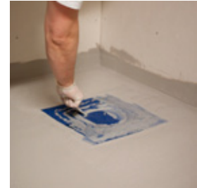
Utjämning av rörmanchett och förstärkningsremsor.
